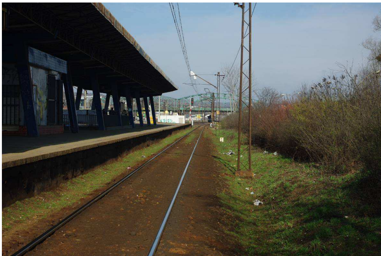
Fot. Zanieczyszczona podsypka w torze nr 501.
